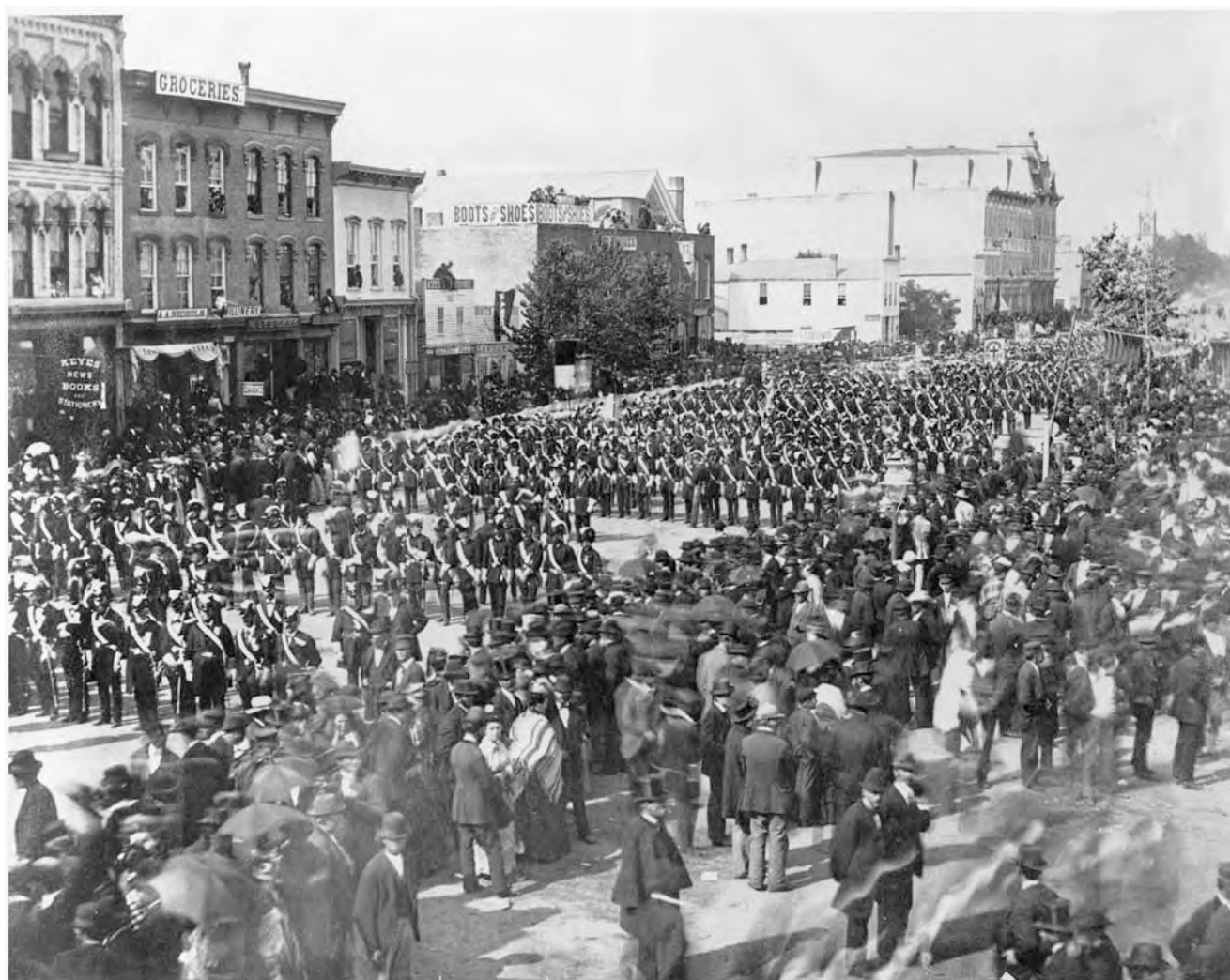
Церемония закладки первого камня в фундамент третьего Капитолия Мичигана, сопровождающаяся парадом 2 октября 1873 г. в присутствии многотысячных зрителей.
